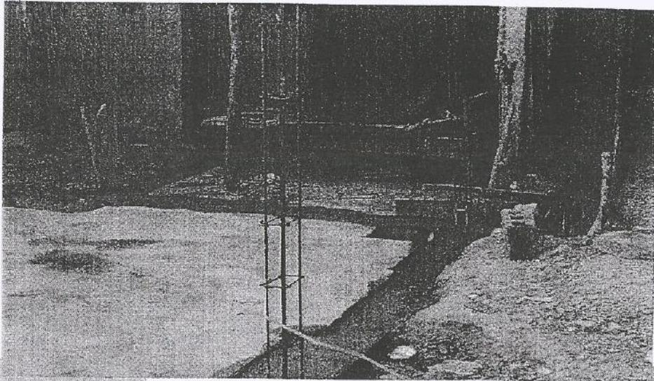
ejecutado: F'CO200 KG/CM2. AGREGADO MAXIMO 3/4", REFORZADA CON 4 VARILLAS DE 3/8", ESTRIBOS DE 1/4" @20 CM., INCLUYE: CIMBRA, DESCIMBRA, 87 MATERIAL, MANO DE OBRA Y EQUIPO
