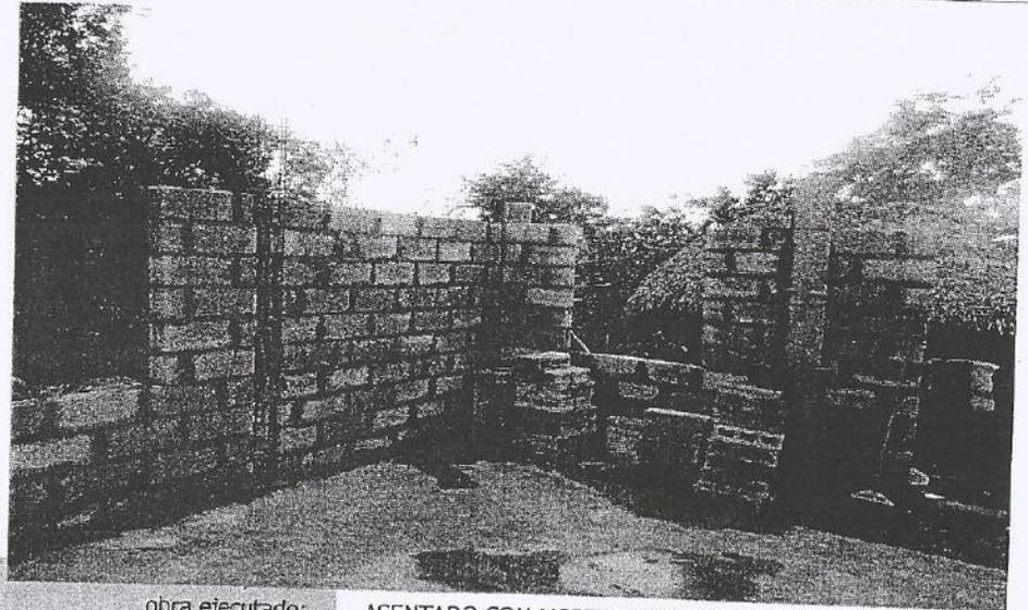
obra ejecutado: ASENTADO CON MORTEROCEMENTO-ARENA 1:5, INCLUYE: MATERIAL, MANO DE OBRA, HERRAMIENTA Y EQUIPO NECESARIO.
