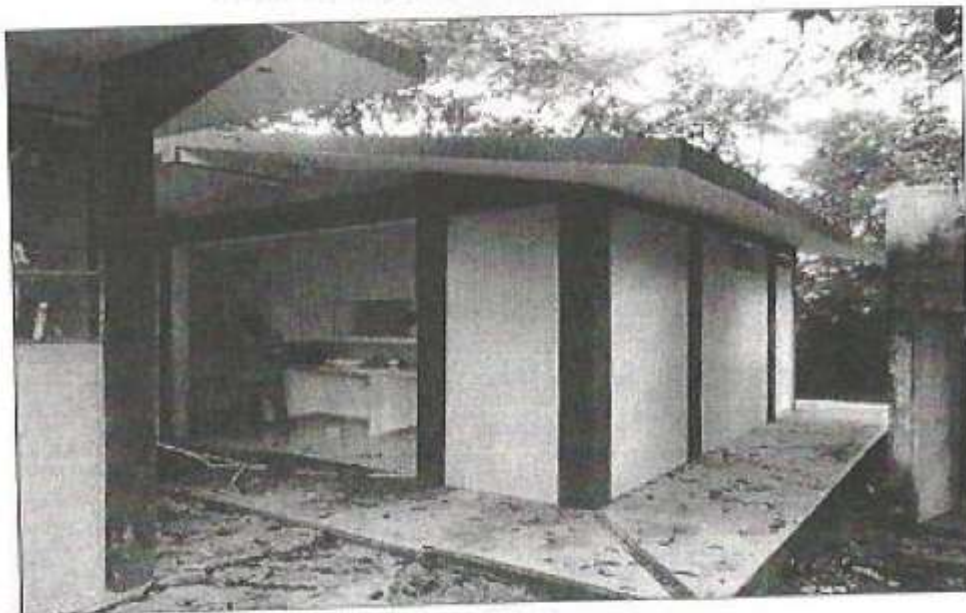
FOTO (12) LIMPIEZA GENERAL DE LA OBRA
