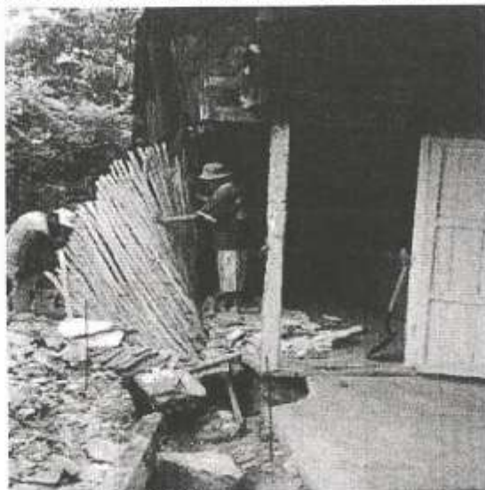
DEMANTELAMIENTO DE MUROS EXISTENTES
